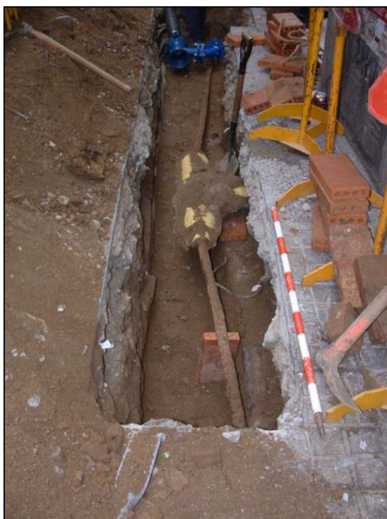
F3: Vista parcial de la rasa en el carrer de l'Hospital
